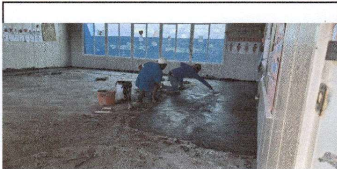
Foto 3: Se está colocando torta de concreto en el aula de preprimaria.
