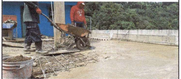
Foto 8: Patio de cocina escolar en proceso de reparación con colocación de planchas de concreto.
