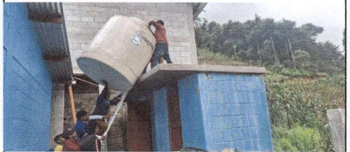
Foto 10: Colocación de depósito de agua en el lugar correspondiente.
