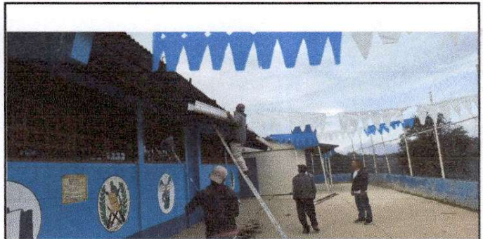
Foto 4: Se están sustituyendo canales y bajadas de agua deteriorados y en mal estado.
