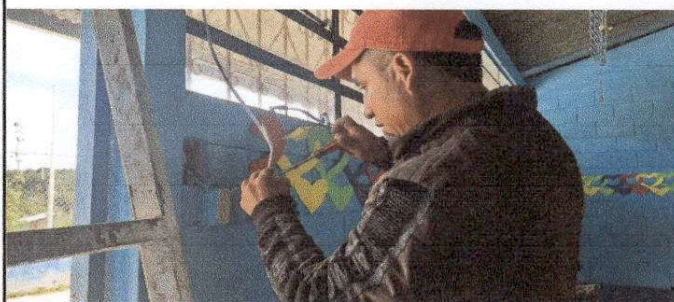
Foto 9: Mantenimiento a instalación eléctrica en las aulas en proceso.
