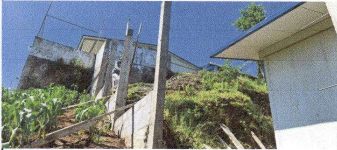
Foto 7: Muro perimetral en proceso de reconstrucción.
