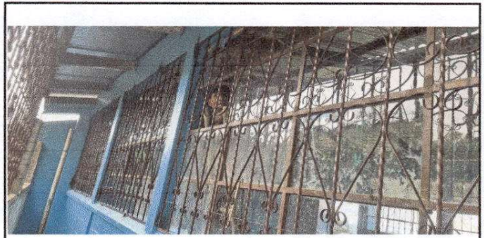
Foto 2: Se están colocando vidrios y posterior a ello se le dio vuelta a seis ventanales de este aula.
