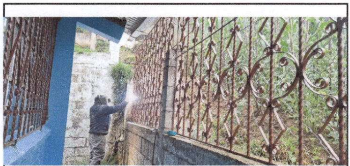
Foto 6: Se está instalando barandas nuevas por deterioro de las anteriores.
